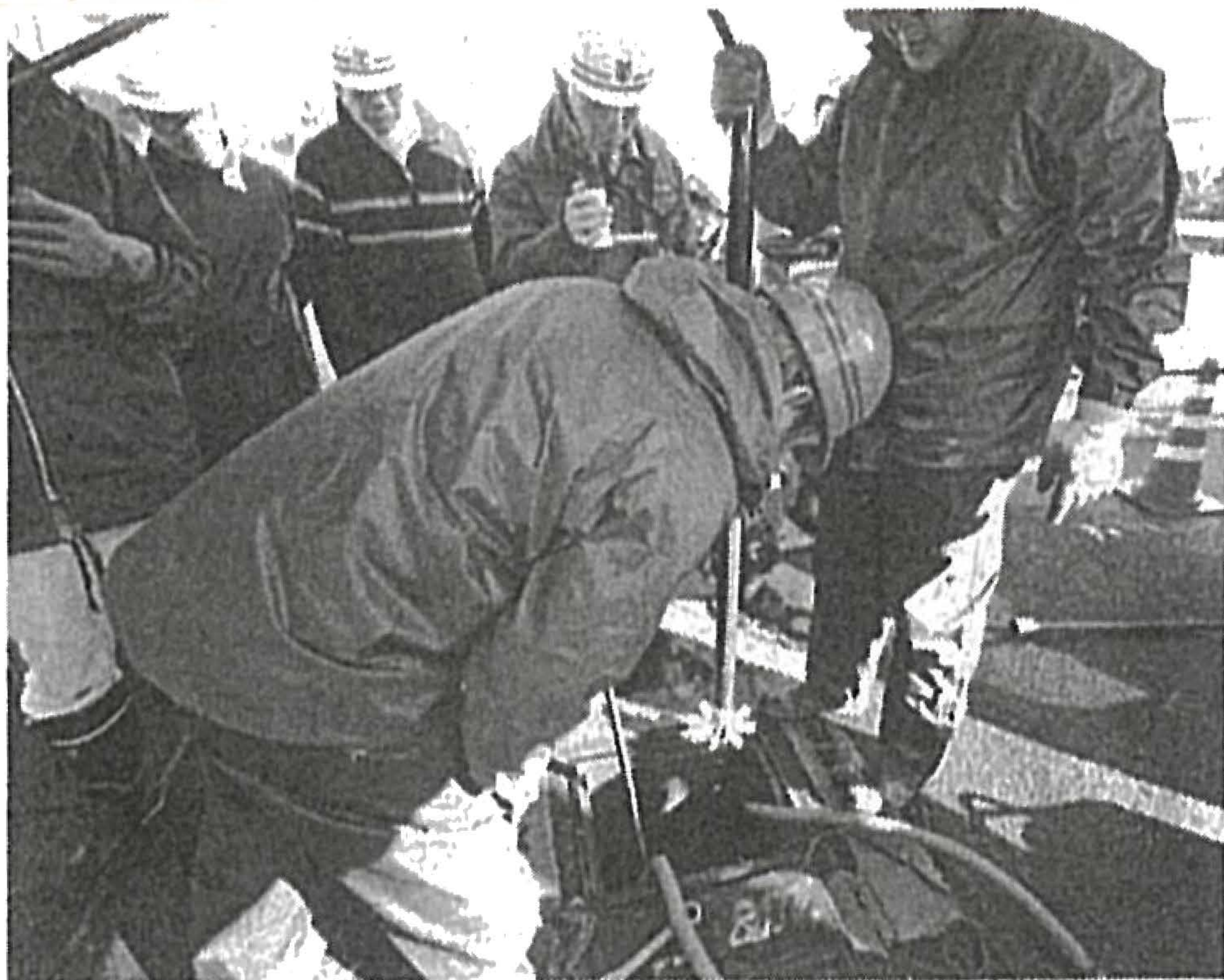
洗浄ヘッドの挿入状況
